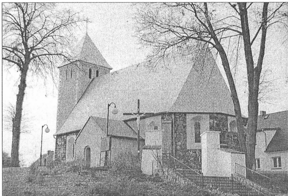
Fot. 1. Kościół katolicki w Ochli – stan obecny [fot. P.Sz. Towpik]
